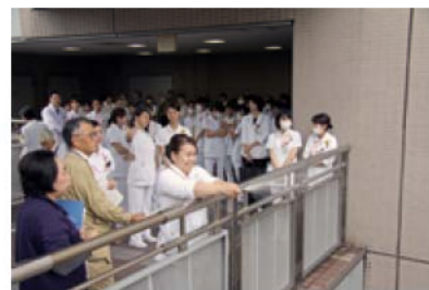
水圧が高い消火器補助散水栓のホースの扱いをスタッフが実際に体験
