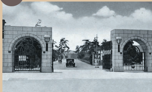
医学部正門(昭和3年竣工) 医学部創立25周年を記念して建造された
