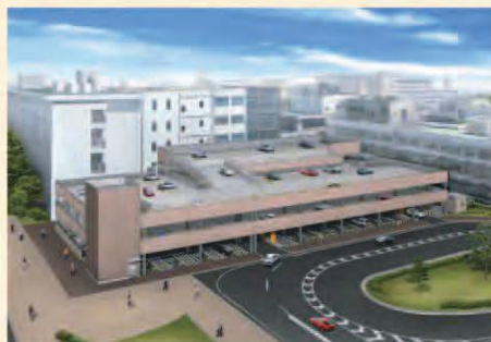
外来診療棟前の新立体駐車場
